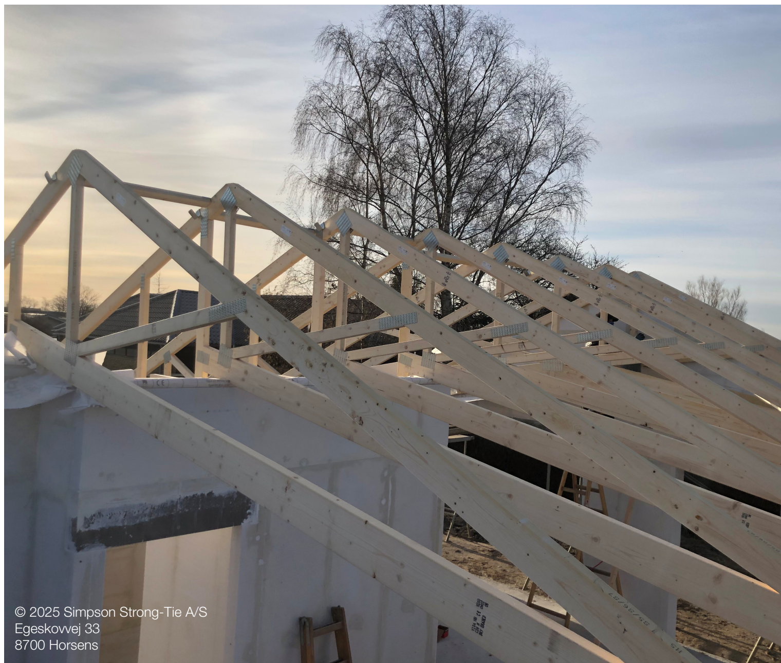
Spærene kan nu kobles direkte på de allerede monterede spær uden behov for mandskab på taget
