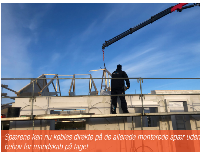
TIC monteres på spærene før spærene hejses op med kran
